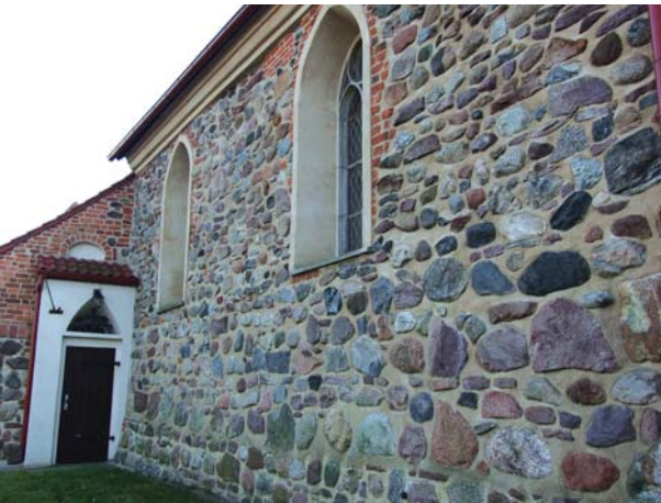
Fot. 2. Mury kościoła – najlepsza pracownia geologiczna (fot. autor)
